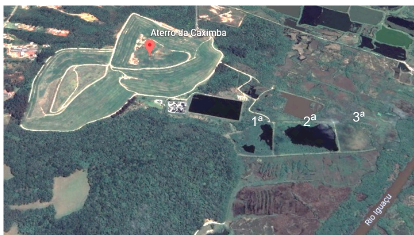
Figura 1. Aterro Sanitário de Curitiba. A área enumerada demonstra as wetlands , sequencialmente, presentes no Aterro Sanitário. Fonte: Google Earth (2019), adaptado.
